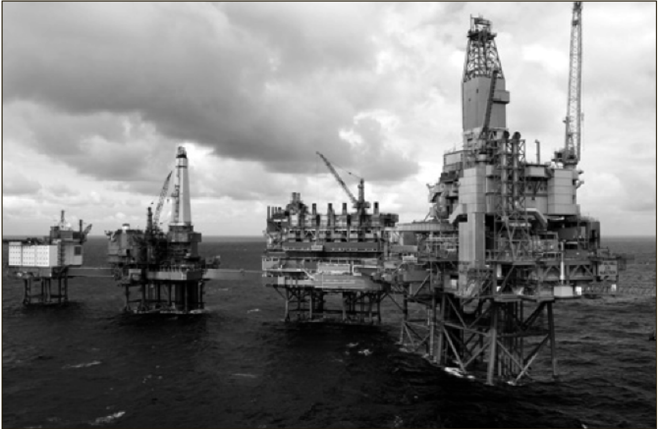
Figur 2.2 Installasjonene på Valhallfeltet i dag er, fra venstre: boligplattform, boreplattform, prosess- og kompresjonsplattform, brønnhodeplattform og injeksjonsplattform
