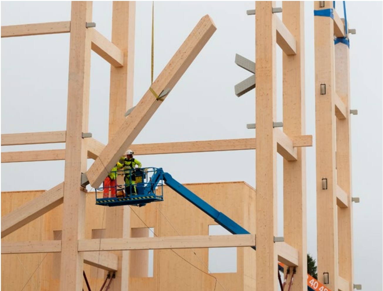
Mjøstårnet blir verdens høyeste trehus (81 meter) og skal etter planen være ferdig i februar 2019. Økt bruk av tre i bygg kan bidra til å øke lagret av karbon i langlevende treprodukter. Foto: Christopher Kunøe / Byggmesteren
