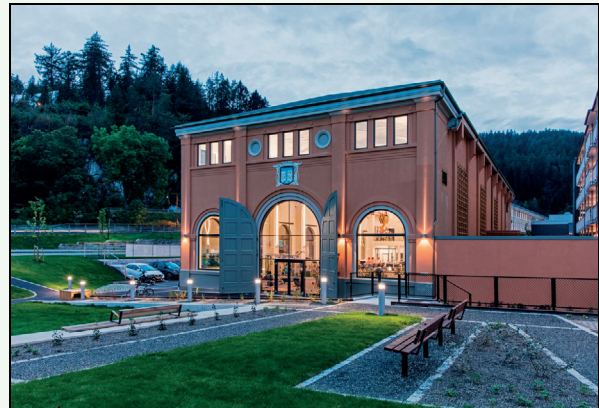
Figur 8.11 Dampsentralen med åpne porter etter istandsetting.
