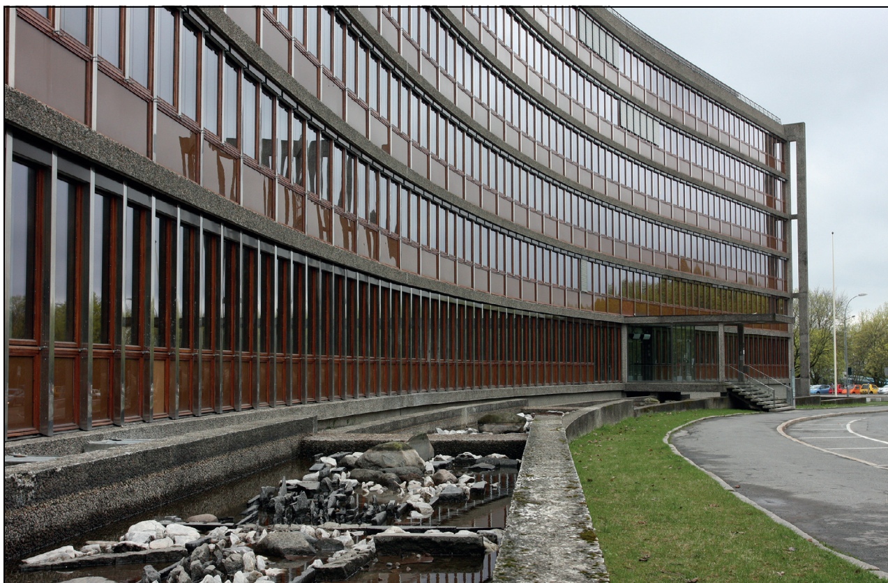
Figur 10.5 Rehabilitering av NVE-bygget.
