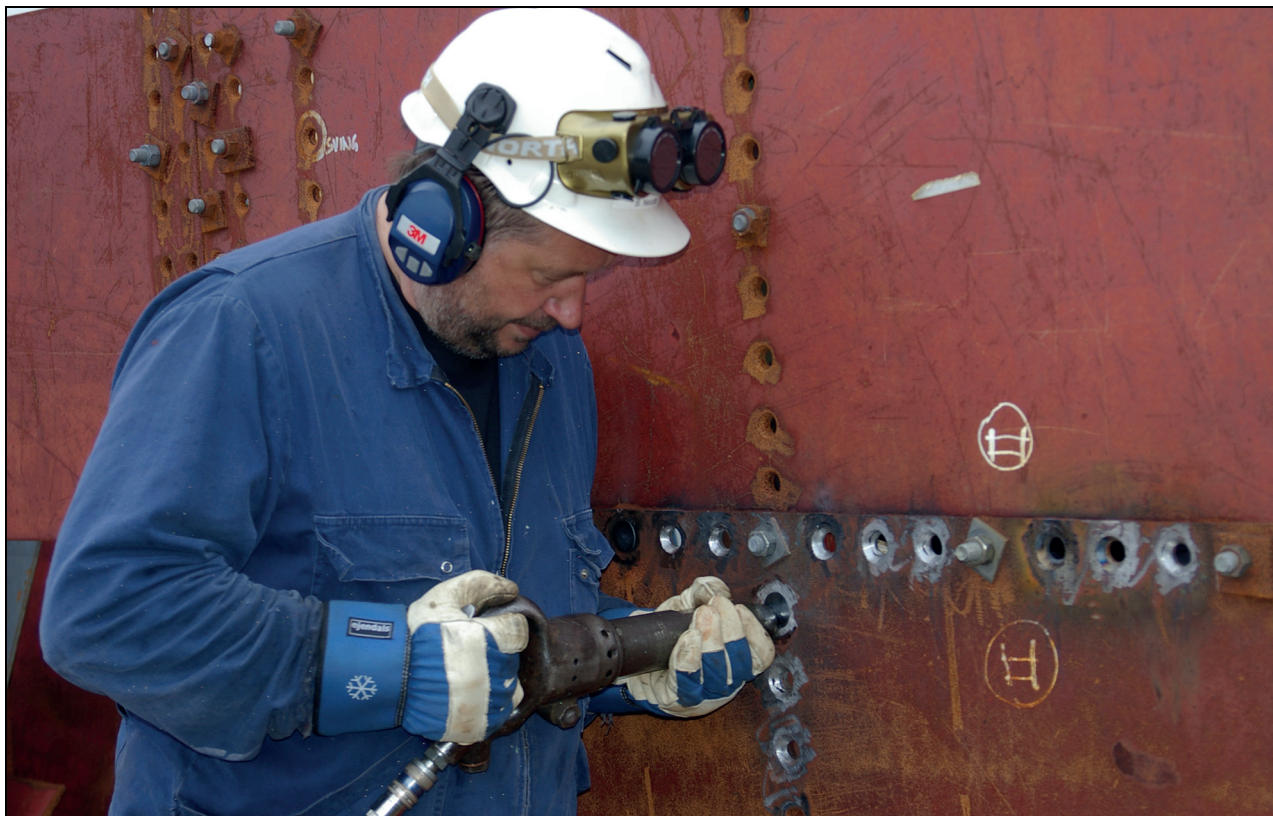
Figur 8.10 Klinking av stålfartøy på Bredalsholmen dokk og fartøyvernssenter.
