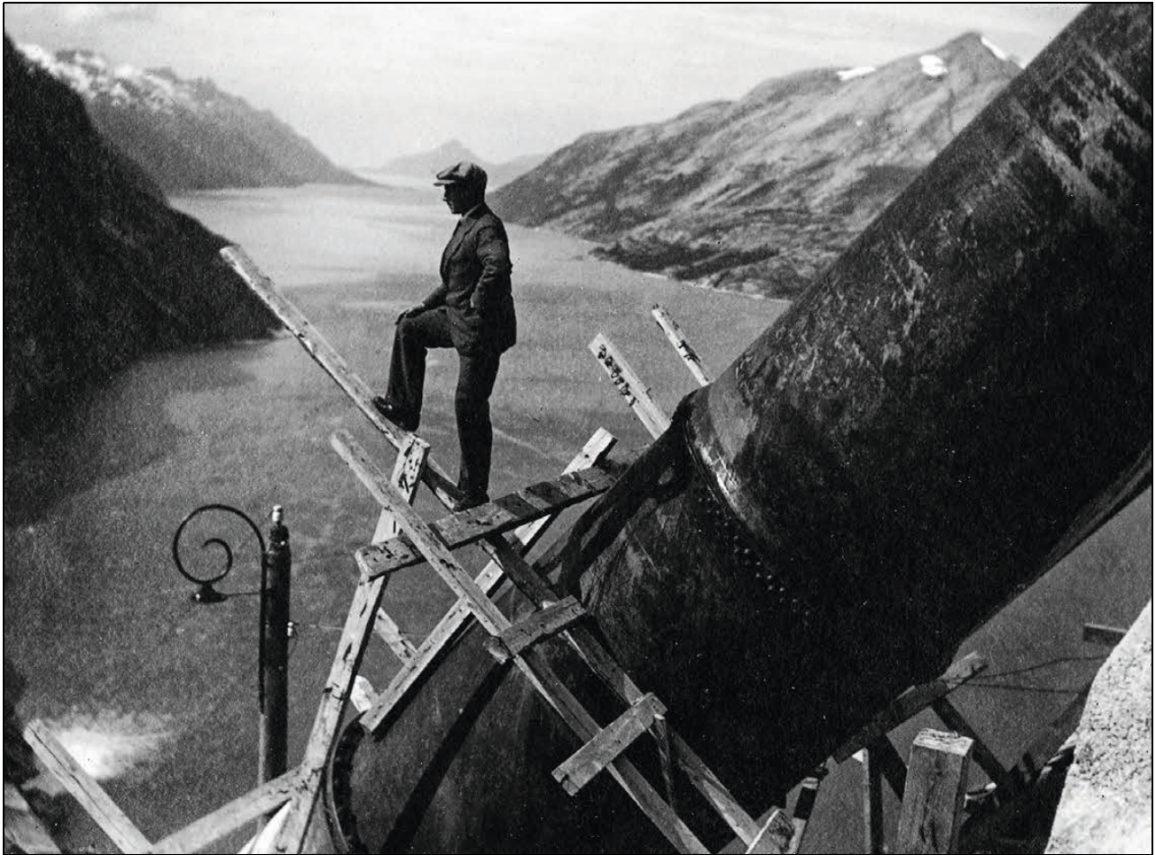
Figur 1.1 Bygging av Glomfjord kraftverk i 1918.
