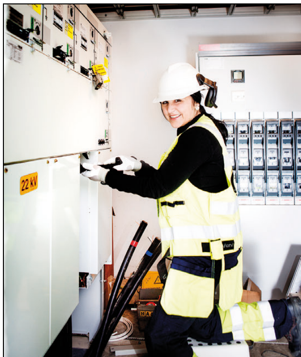
Figur 14.1 Helautomatisk nettstasjon som del av et smartere distribusjonsnett.
