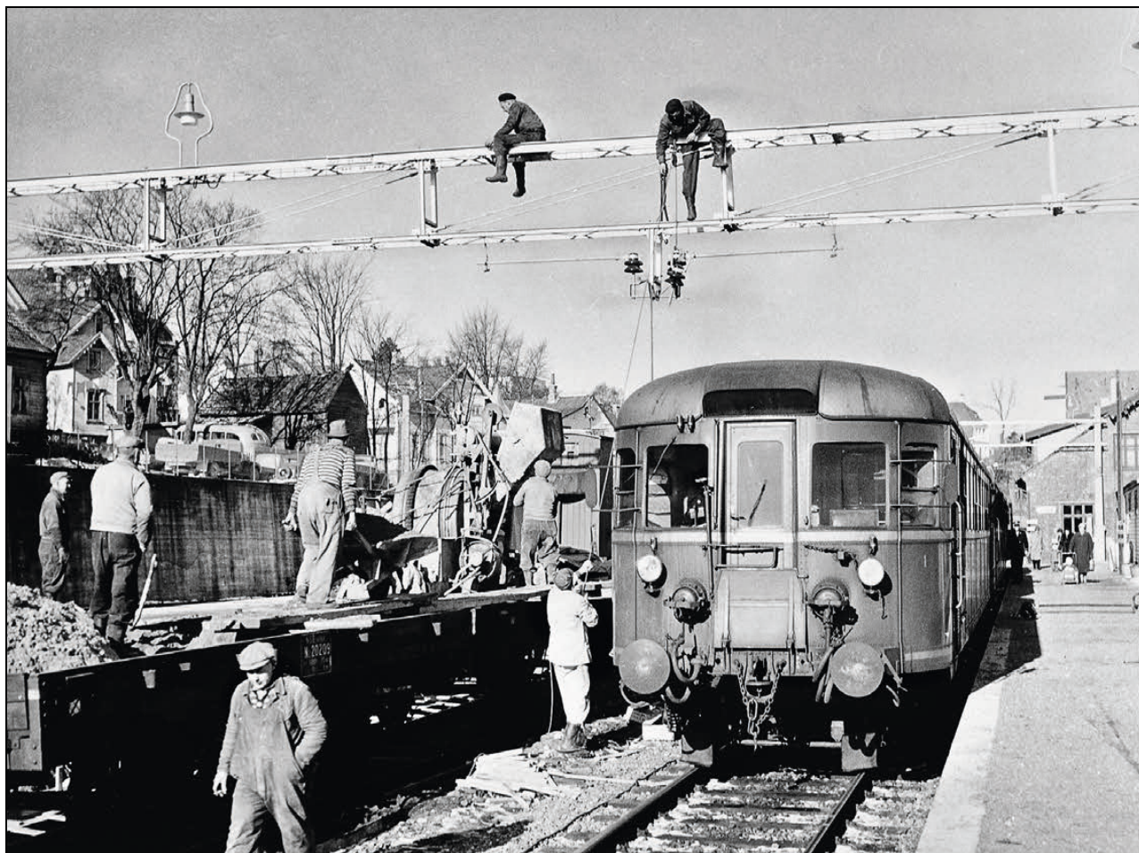
Figur 2.11 Jernbanens elektrifisering: Montering av kontaktledningsanlegget på Stavanger stasjon.
