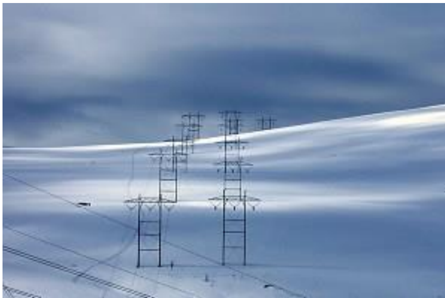
Figur 15: Parallelle traséer oppfattes gjerne som mest ryddige når man har samme mastetype. Her er 132 kV ledningene mellom Kvandal – Kanstadbotn og Kvandal – Kvitnes. Foto: Statnett.
