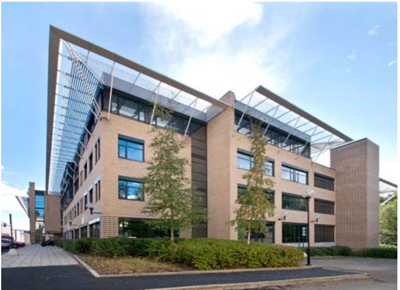
Justisdepartementet var ferdig innflyttet på Gullhaug Torg i Nydalen i februar 2013. Her befinner departementet seg midlertidig i påvente av å flytte tilbake til regjeringskvartalet. Foto: Avantor
