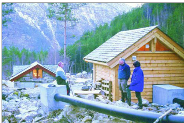
Figur 17.2 Minikraftanlegg er normalt et vesentlig teknisk inngrep med en installasjon opp mot 1000 kW. Her fra Ullensvang kommune, elva Vivippo, sideelv av Kinsovassdraget.
