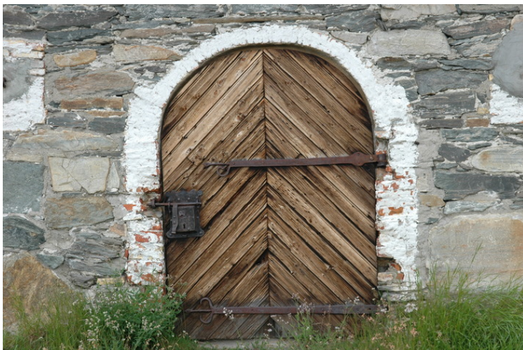
Inngangsdøra på Krutthuset, teglmurte partier rundt åpningen. Foto: Jon Holm Lillegjelten
