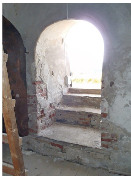
Inngangspartiet er teglmurt. Foto: M.Oftedal, Forsvarsbygg.
