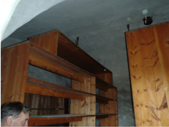
Pussede vegger og hvelving. Foto: M.Oftedal, Forsvarsbygg.
