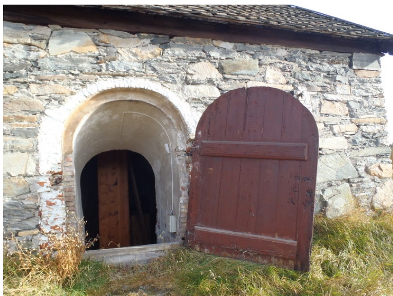
Inngangspartiet. Foto: M.Oftedal, Forsvarsbygg.
