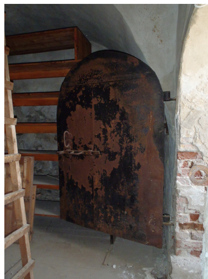
Innvendig jerndør. Foto: M.Oftedal, Forsvarsbygg.
