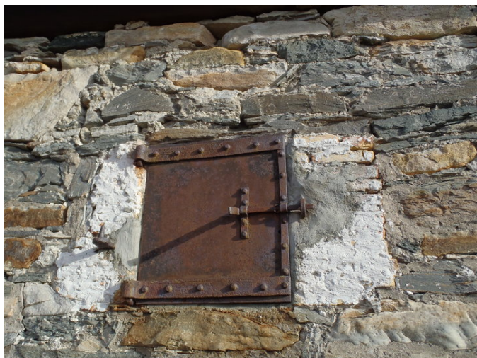
Jernluker foran åpninger for lufting. Foto: M.Oftedal, Forsvarsbygg.
