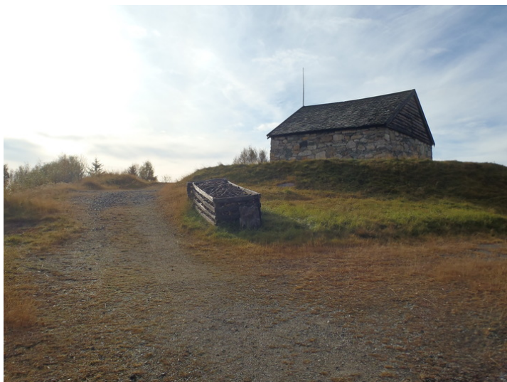
Adkomst fra nordsiden. Foto: M.Oftedal, Forsvarsbygg.
