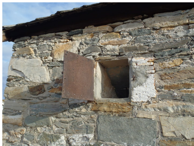
Teglmur rundt åpninger for lufting. Foto: M.Oftedal, Forsvarsbygg.
