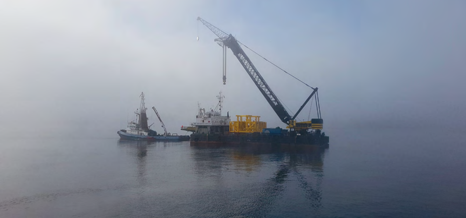
Pumpestasjon og havbunnsramme fra Radøygruppen og OneSubsea leveres til Shell på verdens dypeste felt på 2900 meter i Mexicogulfen. Foto: Shell
